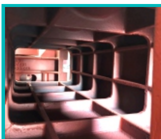
Vnitřní žebrování sloupu
